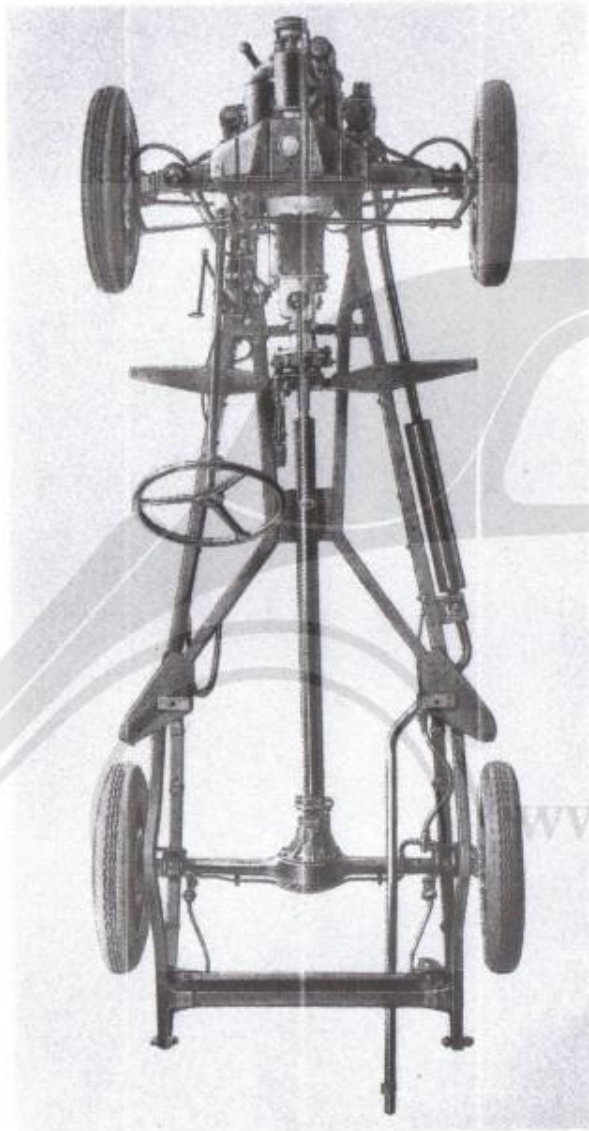
Fig. 4. - Autotelaio mod. 500 dal N. 046001, visto dall'alto.
